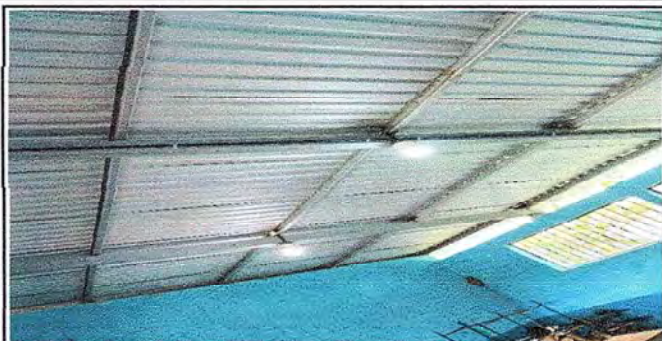
Foto 2: La fotografía evidencia nuevas iluminaciones eléctricas del remozamiento ejecutado al 100%.
