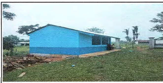
Foto 6: Esta fotografía evidencia la finalización en su totalidad del remozamiento de la Escuela Oficial Rural Mixta Caserío Arenal II.
